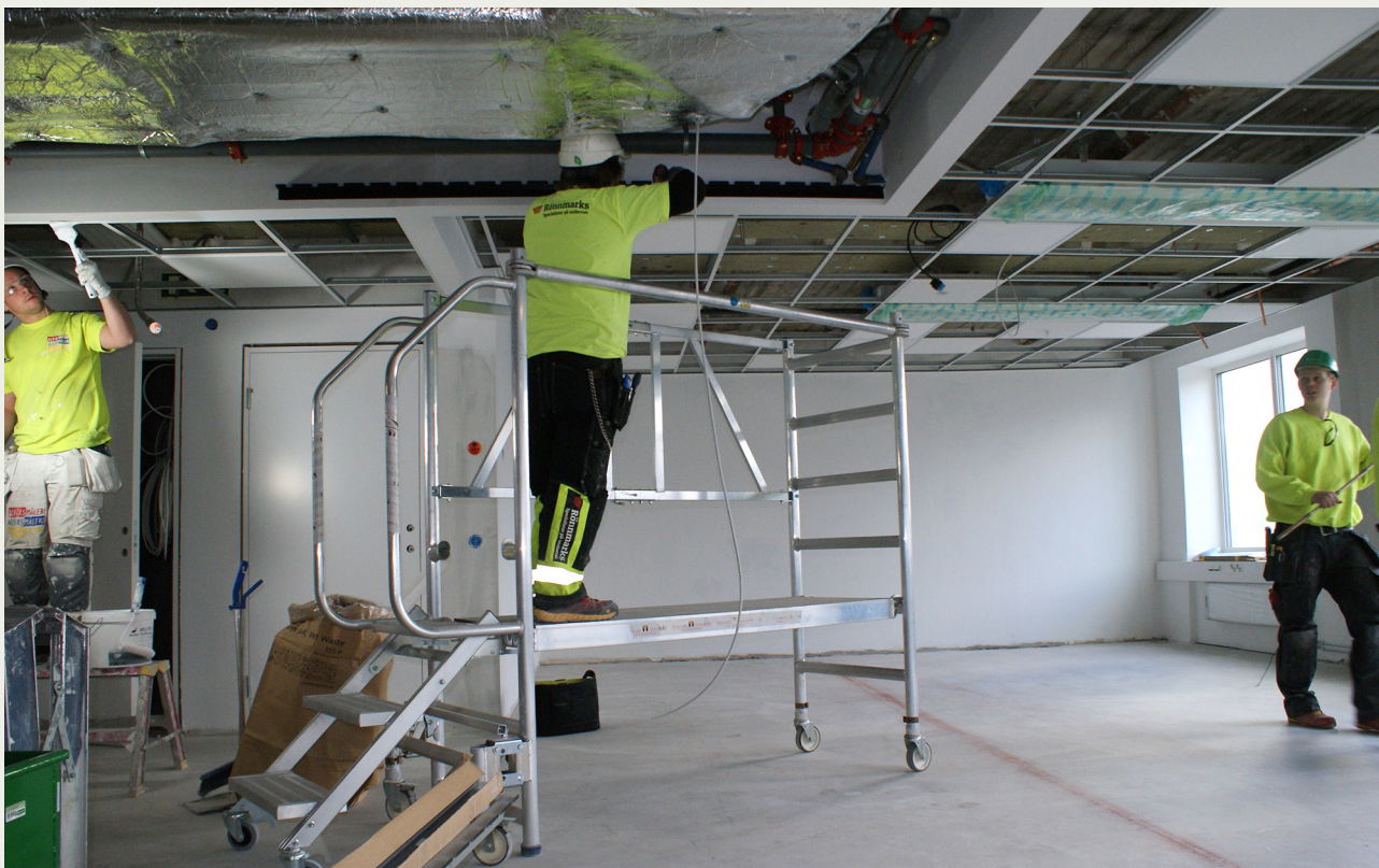
Bild 4: Ställningshjulet låses med pedal. Upplåsning via koppling till handledarens förlängning och stödben (till höger i bild).
